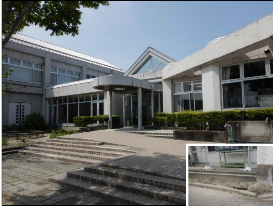
軟弱な地盤の影響により、 建物外周部分が沈下している。
