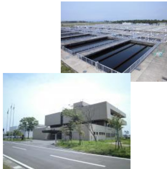
図 2-3 県南浄化センター
