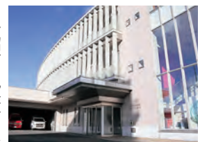
▶岩沼市に設置されるあぶくま消防本部
