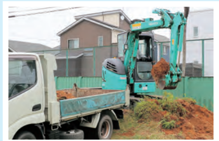
▲残土処分作業 (玉浦中)
