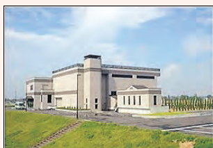
▲押分排水機場（ポンプ場）
