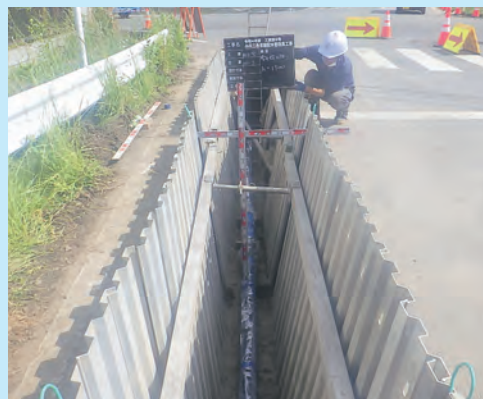
▲水道管更新工事の様子
