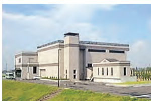
▲押分排水機場
