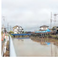
▲現在工事中の岩沼橋
