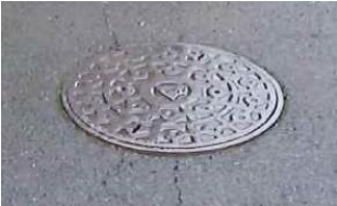
古いマンホール蓋
