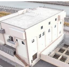
矢野目排水ポンプ場
