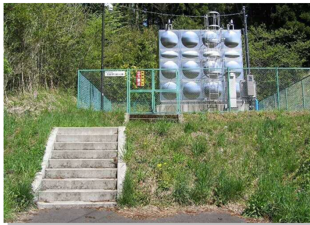
志賀第一配水池
