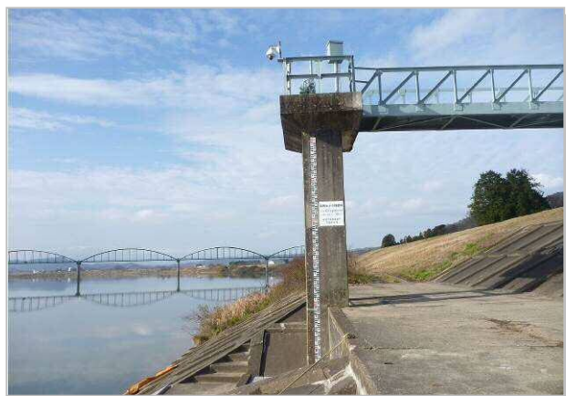
玉崎浄水場取水門 (阿武隈川表流水)
