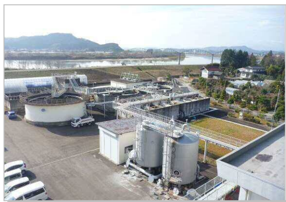
玉崎浄水場全景
