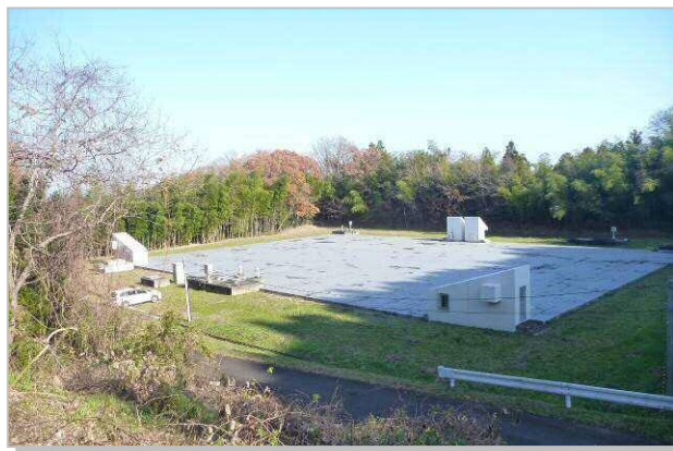
根方低区配水池
