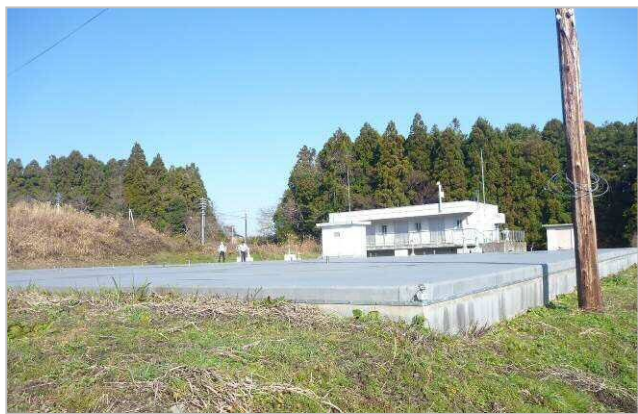
根方高区配水池
