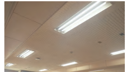
LED化した岩沼小学校本校舎
