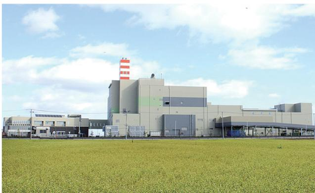
新ごみ処理施設は、ごみを焼却処理する熱回収施設に併設して、分別回収された資源ごみ等を処理するリサイクルセンターを備え、総合的にごみ処理を行うことが可能な施設です。熱回収施設では、ごみを燃やしたときの熱エネルギーを利用し蒸気をつくり発電を行い、施設内で使用する電力を賄うことから地球温暖化防止、循環型社会の形成に貢献する施設でもあります。事前の申込みにより施設見学もでき、小学校の社会科見学や中学校の総合学習等での団体見学も受け入れています。
