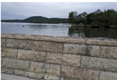
松島海岸の防潮堤
