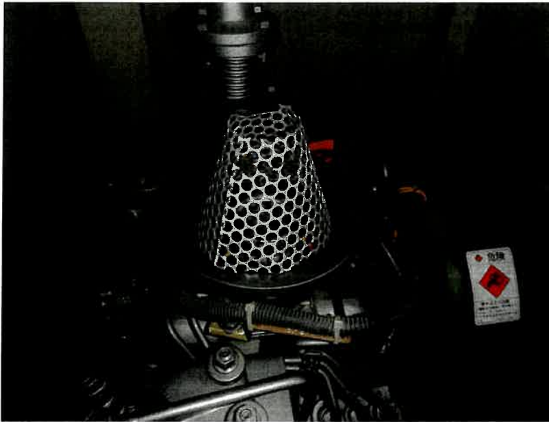
吸気フィルター 経年劣化
