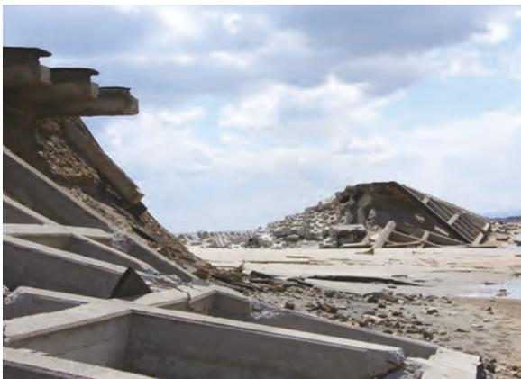
津波で破堤した海岸堤防
