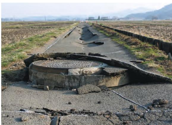
2011 年（平成 23 年）4 月 15 日、道路が陥没しマンホールが浮き上がった市道松ヶ丘根方線
